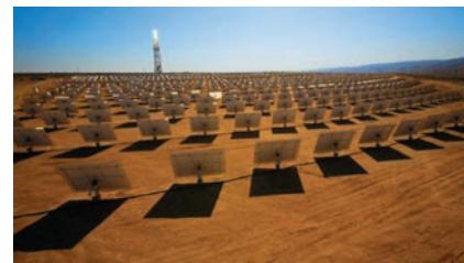
■ GPS-датчики позволяют панелям отслеживать солнце и поворачиваться вслед за ним
