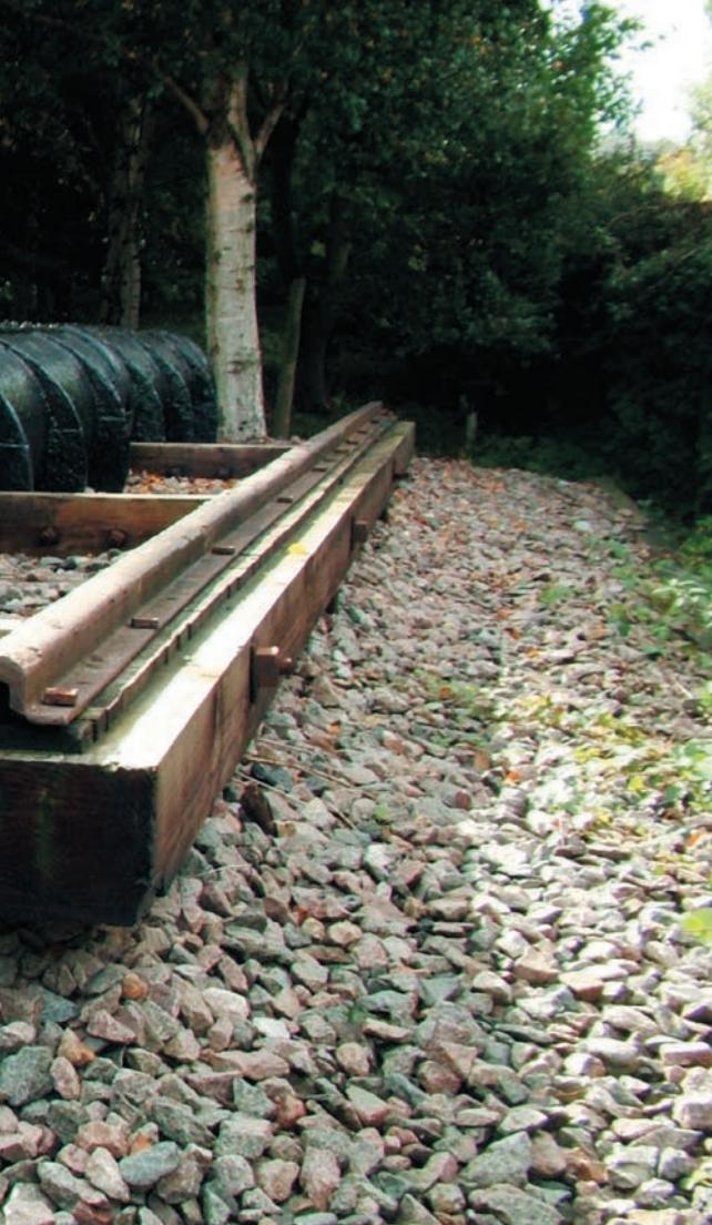
с головным вагоном поршнем; продольная прорезь в трубе закрыта канатом, покрытым жиром; при проходе вагона канат отодвигается, после чего воздух, устремляющийся в трубу, толкает состав вперед.
